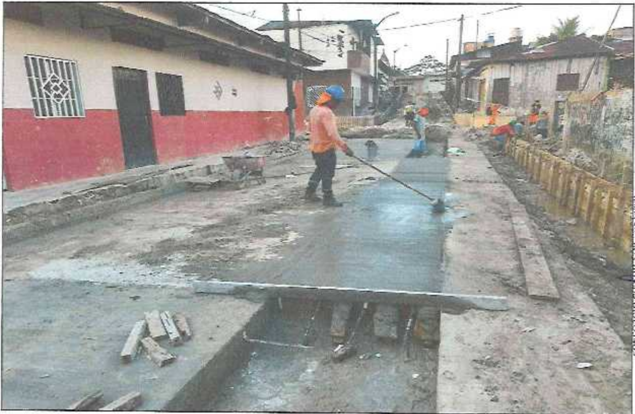
VISTA FOTOGRAFICA N° 08: VACEADO DE LOSA DE RODADURA EN CALLE SALAVERRY.
