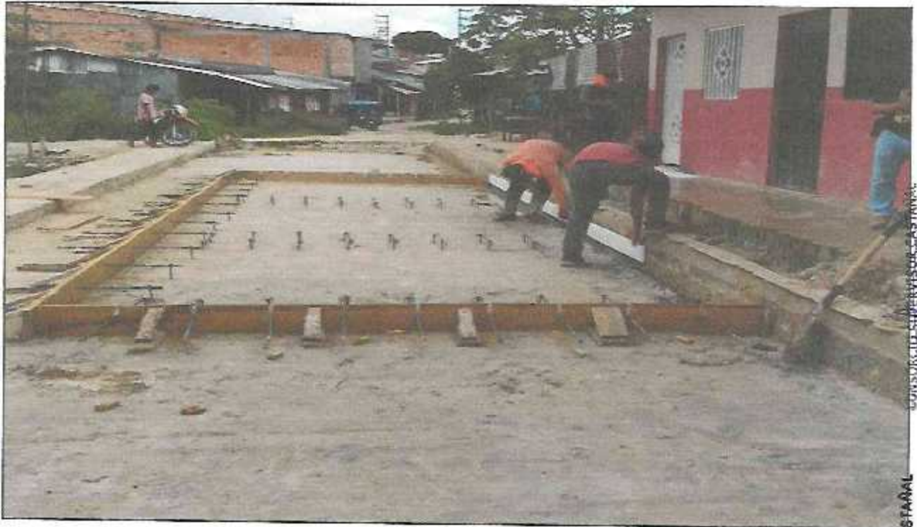
VISTA FOTOGRÁFICA N° 10: VACEADO DE LOSA DE RODADURA EN CALLE SALAVERRY.
