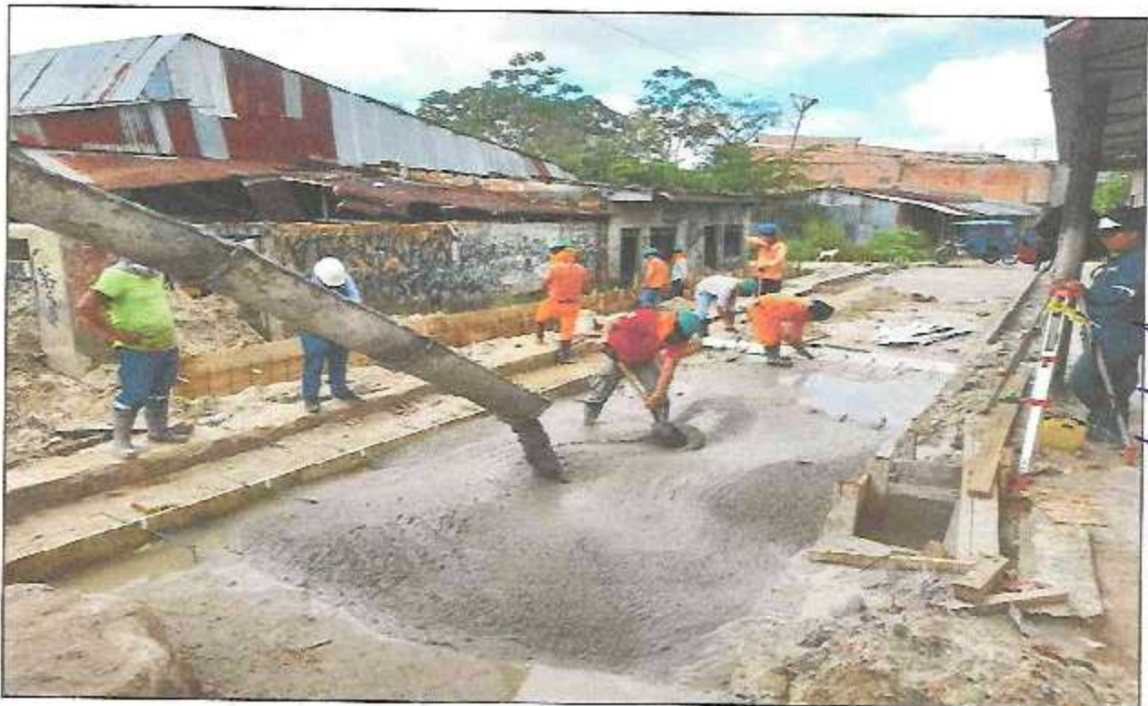
VISTA FOTOGRÁFICA N° 06: VACEADO DE LOSA DE RODADURA EN CALLE JUNÍN TRAMO III.
