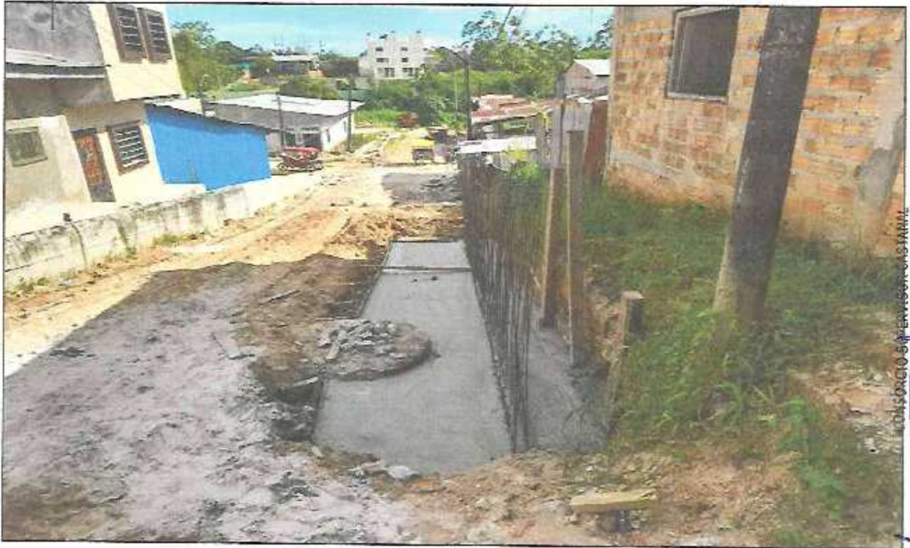
VISTA FOTOGRÁFICA N° 16: ACERO CORRUGADO \varnothing 1/2" , f_y = 4200 \text{ Kg/cm}^2 EN MURO DE CONTENCIÓN TIPO I.
