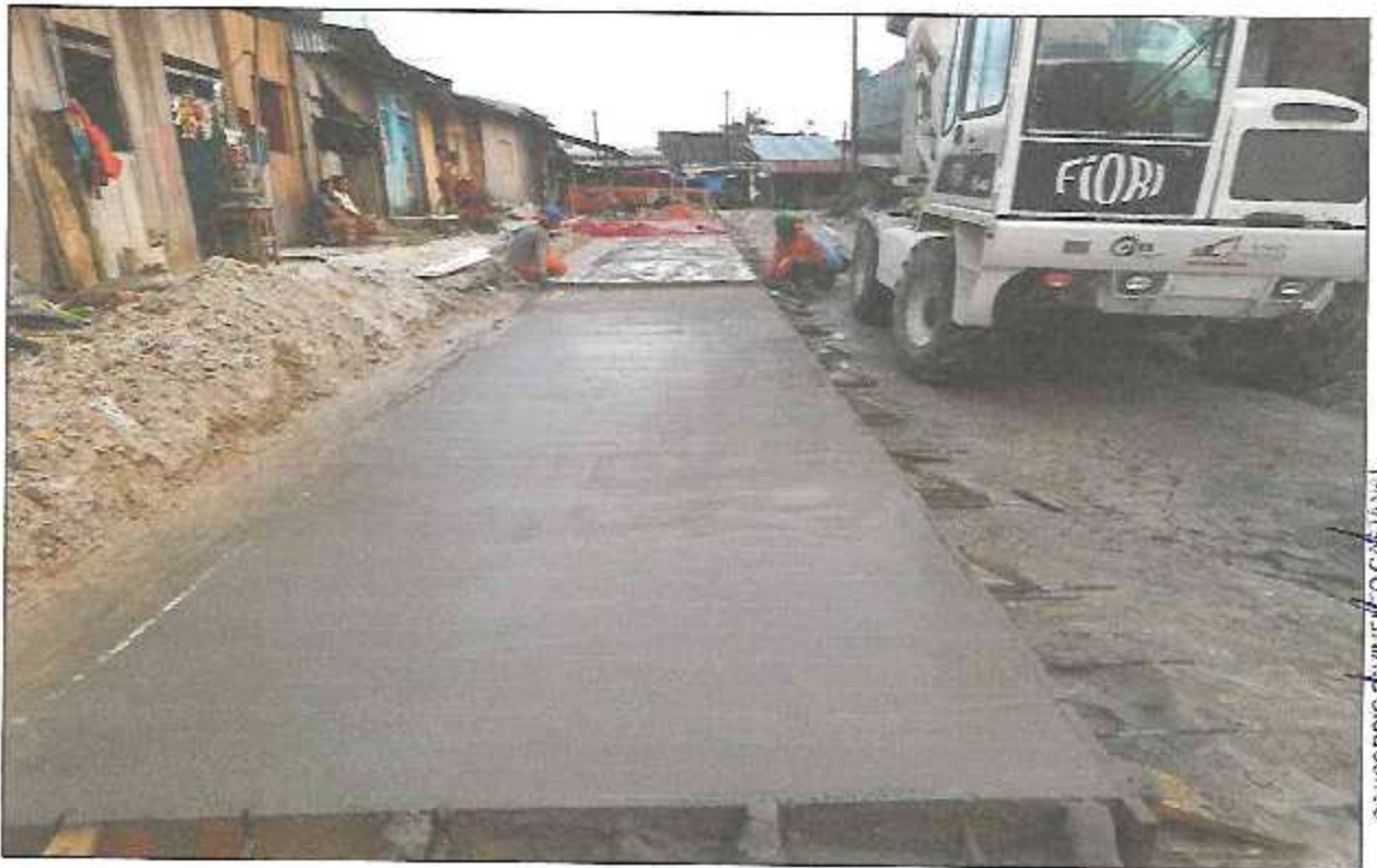
VISTA FOTOGRAFICA N° 08: VACEADO DE LOSA DE RODADURA EN CALLE SALAVERRY.
