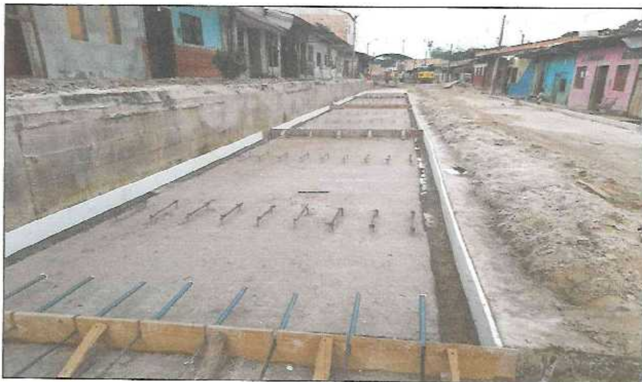
VISTA FOTOGRÁFICA N° 12: ACERO CORRUGADO Ø 1/2" EN CANAL RECTANGULAR EN CALLE SALAVERRY.
