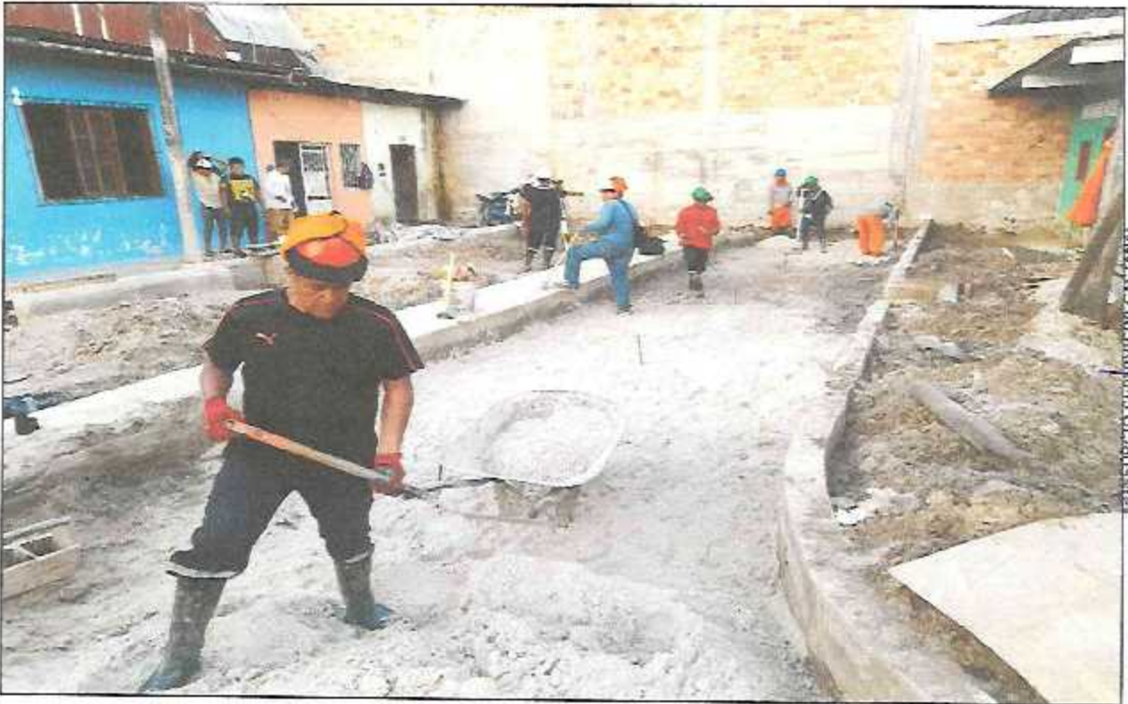
VISTA FOTOGRÁFICA N° 06: VACEADO DE LOSA DE RODADURA EN CALLE JUNÍN TRAMO III.
